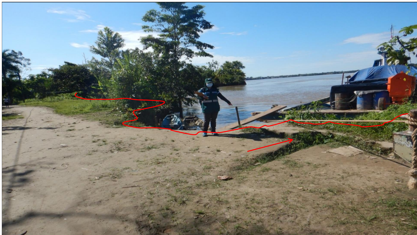
FIGURA N°02: VEREDAS PEATONALES QUE HAN QUEDADO ENTERRADAS O SE PERDIERON POR LA EROSIÓN DEL SUELO EN LA RIBERA.
