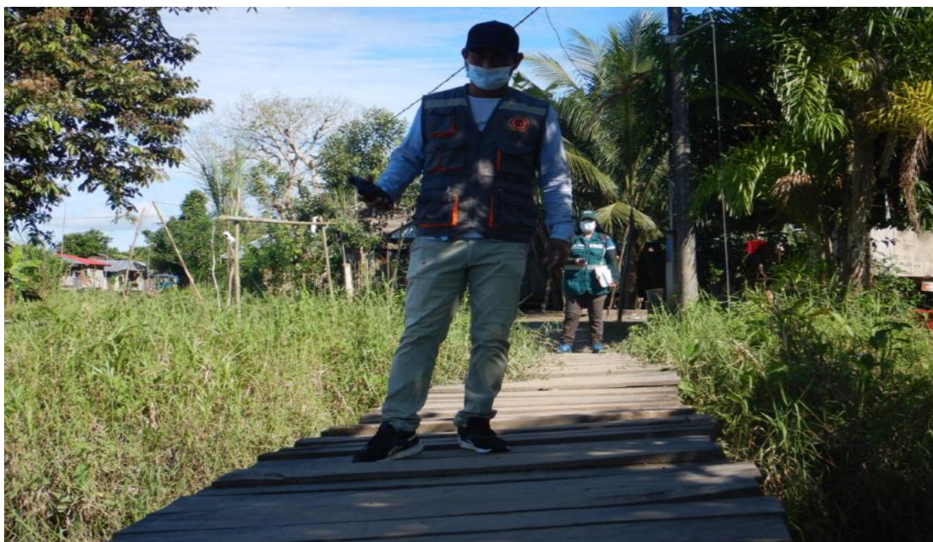
FIGURA N°01: PUENTE DE MADERA QUE CONECTA CON EL BARRIO HUACACHINA, SE AFECTA EN PERIODOS DE INUNDACIÓN, SE REPARA FRECUENTEMENTE.
